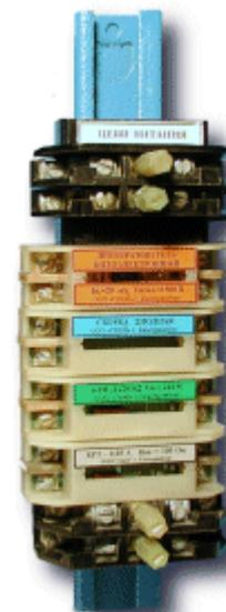
Конструктивно реле выполнены в корпусах-клеммах, которые легко устанавливаются на панелях в ряд клеммных зажимов.
